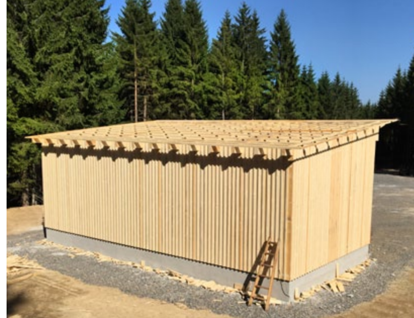
Halle von Holzbau Bernhard Bauer
